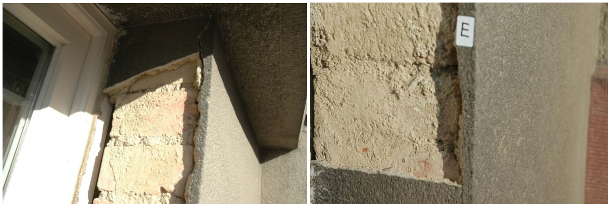
Obr. 4: Vlevo: poškozené omítkové souvrství u okenní špalety, vpravo: místo odběru vzorku E
