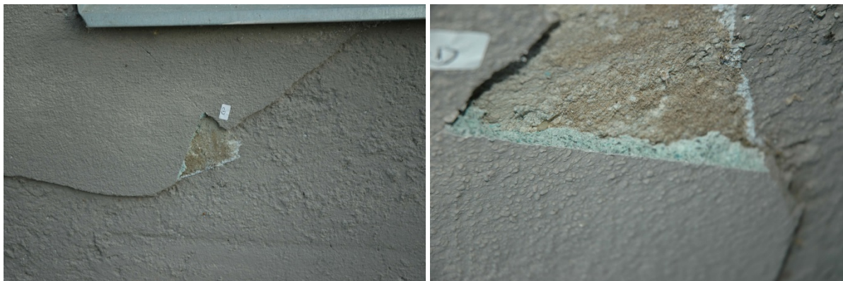
Obr. 5: Vlevo: místo odběru vzorku G, vpravo: detail probarvené teracové omítky soklové partie
